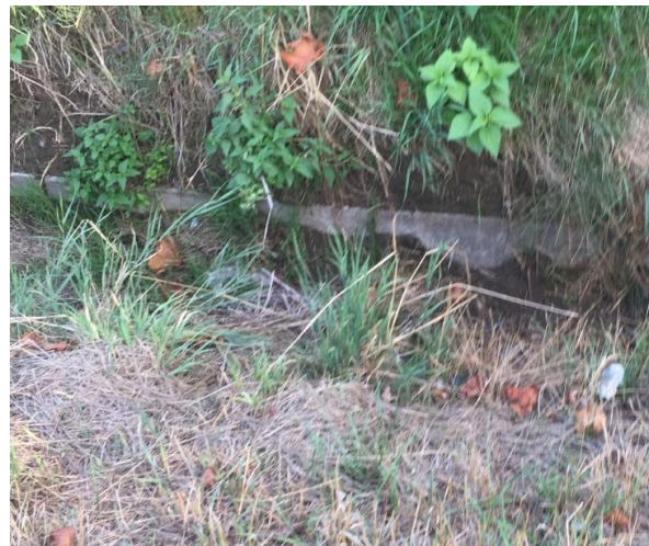
Betonsohle Abschnitt A2
